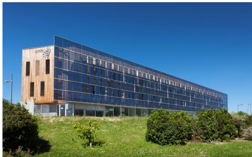
Vue de la façade Sud du bâtiment
