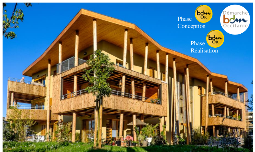
Vue du bâtiment B depuis le Jardin, façades sud et ouest. Photo Frédéric Jozon
