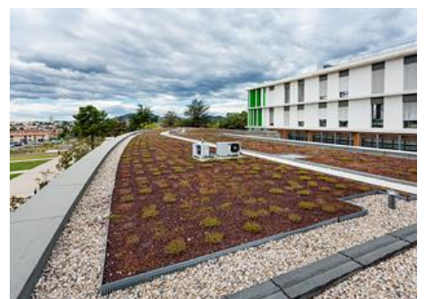
Toitures terrasses végétalisées
