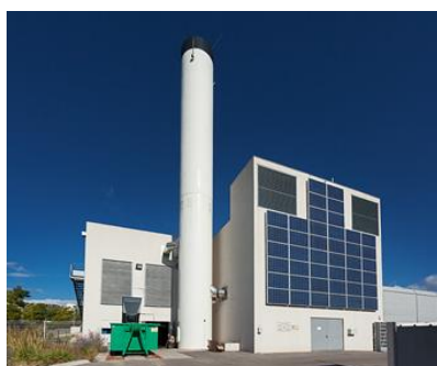
La chaufferie bois énergie, sa façade photovoltaïque et l'installation d'eau chaude solaire
