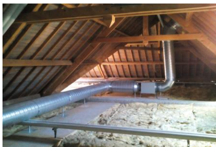
Isolation en toiture et VMC simple flux Photo David ARNAUDON/ADEME
