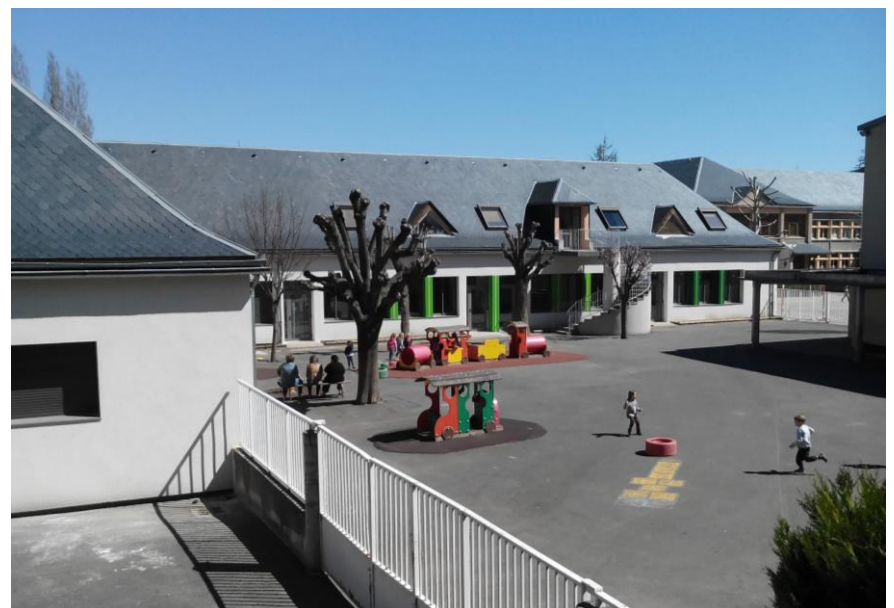
Vue générale de l'école maternelle après rénovation thermique des bâtiments Photo David ARNAUDON/ADEME
